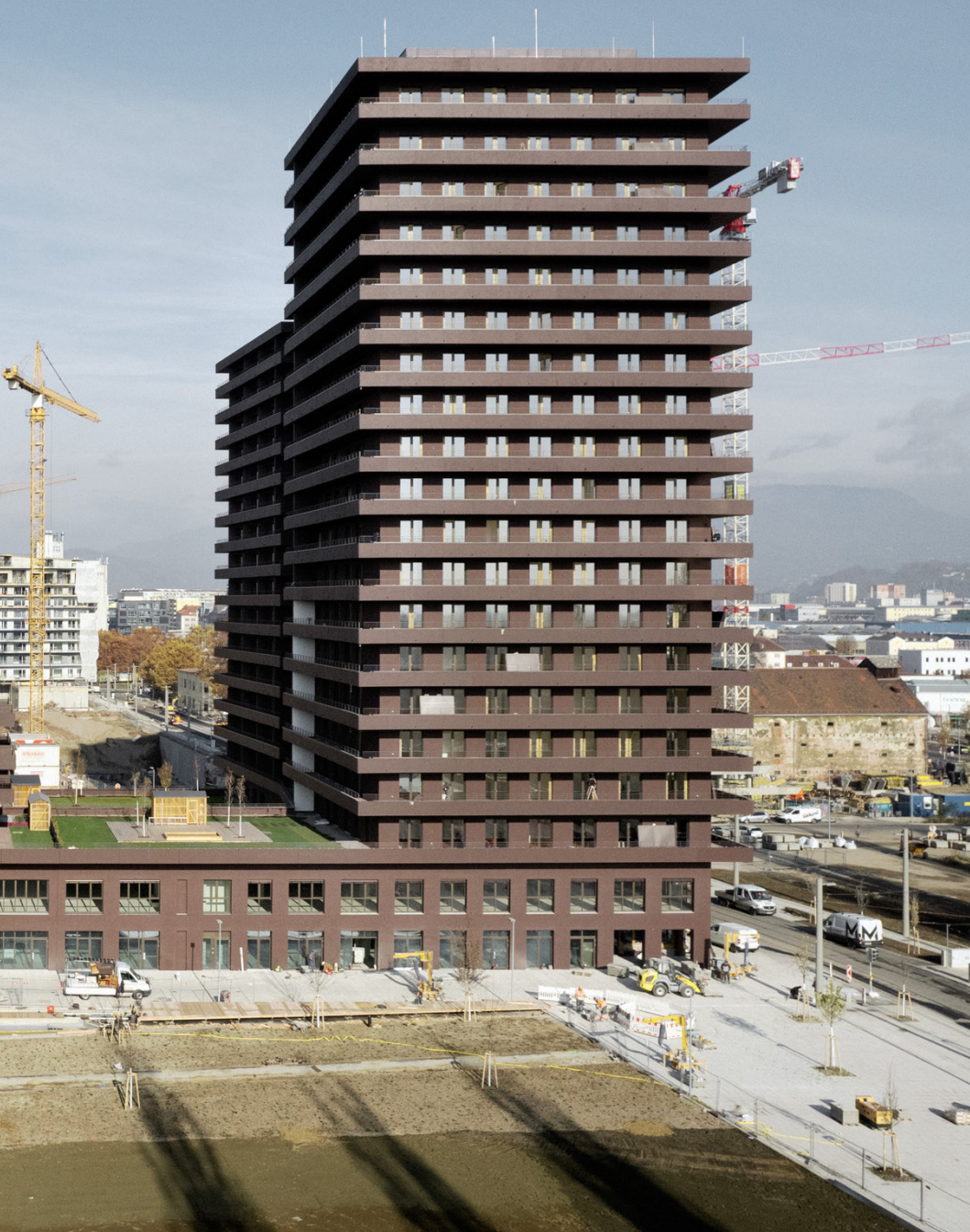
Reininghaus, Graz (Autriche) Copyright: Reininghausgrnde
